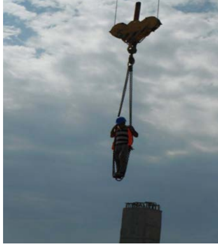
Şekil 18. Zincir ile uygunsuz şekilde insan taşınması
