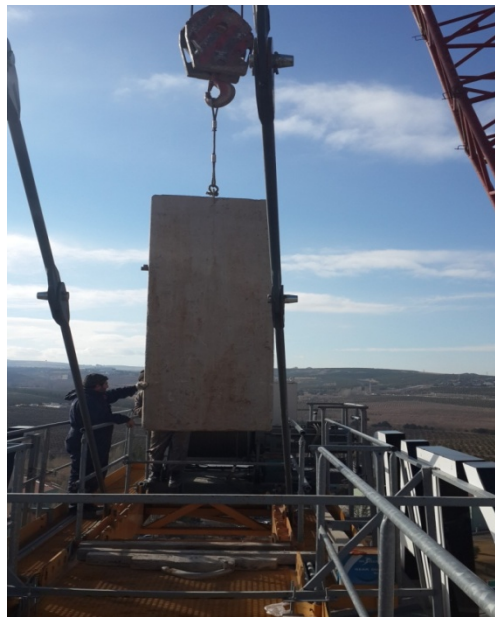
Şekil 50. Kuyruk grubu denge ağırlıklarının yerleştirilmesi
