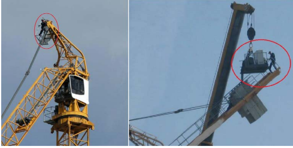
Şekil 82. Tedbir alınmadan yüksekte çalışılması
