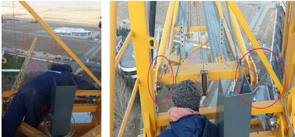
Şekil 74. Kuyruk grubunun ve bomun sökülmesi-emniyet halatları
