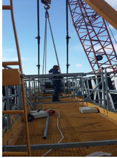
Şekil 56. Kuyruk grubunda reklam tabelasını tutan profiller
