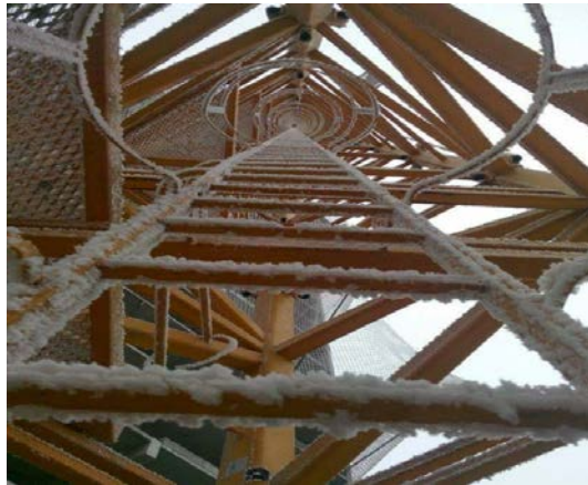
Şekil 44. Buzlu merdiven ve çelik yapı
