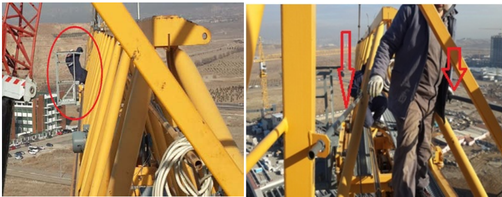
Şekil 57. Arabadan boma ve bomdan kuleye geçilmesi
