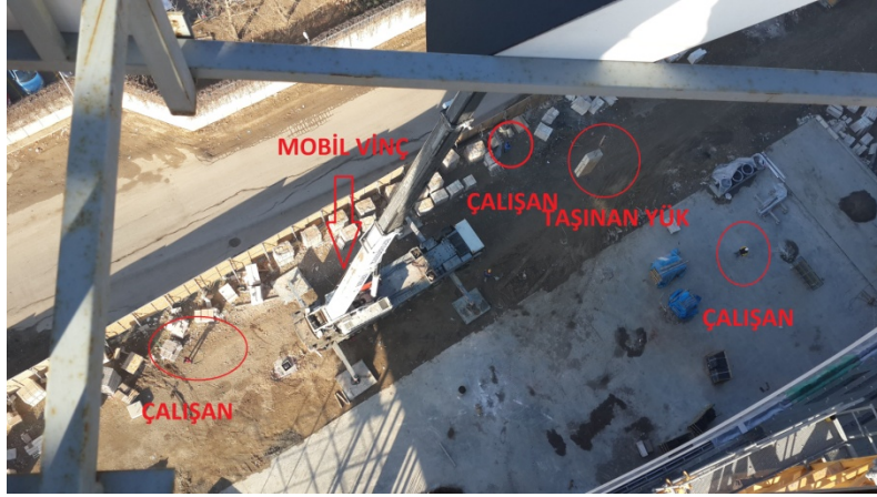
Şekil 73. Kule vincin sökülmesi ve mobil vinç çalışma alanı
