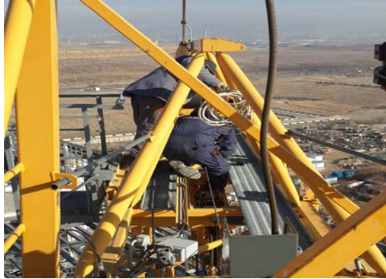
Şekil 80. Kule vinç üzerinde ergonomik olmayan durumlarda çalışma
