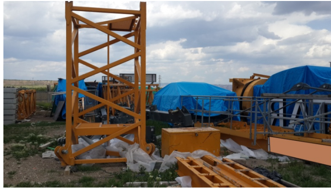
Şekil 79. Kule vinç stoklama sahası
