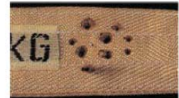
Aşırı sıcaklık nedeniyle hasarlanmış.
