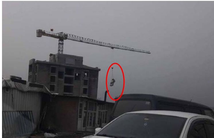
Şekil 59. Kule vincin uygunsuz kullanımı
