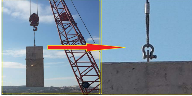
Şekil 32. Beton kuyruk denge ağırlığının kilit-mapa ve tel halat ile taşınması
