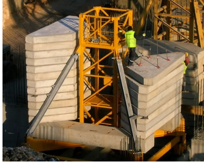
Şekil 48. Taban elemanı ve denge ağırlıklarının yerleştirilmesi
