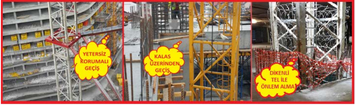
Şekil 62. Vinç-bina geçiş yolu
