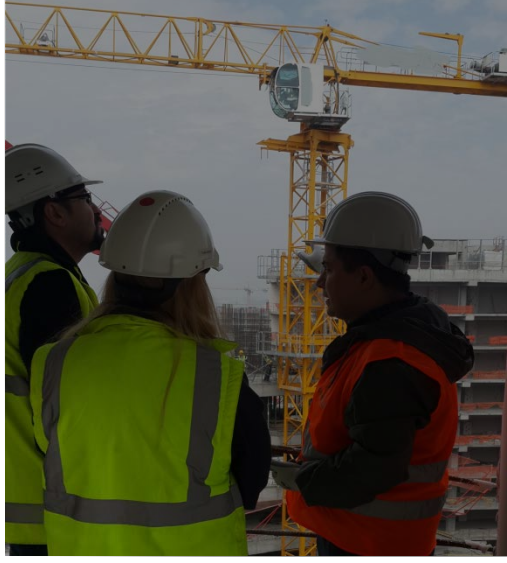
Şekil 34. Kule vinç kontrolleri
