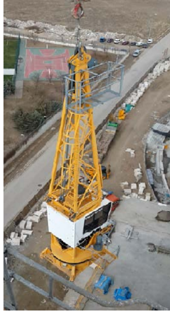
Şekil 76. Kule vinç kabin grubu çıkış merdiveni
