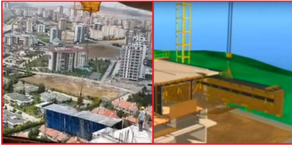
Şekil 64. Kule vinç ile tünel kalıp sökümü
