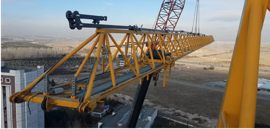
Şekil 51. Bomun tek parça halinde taşınması
