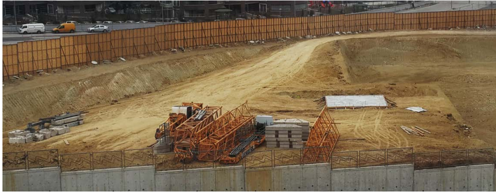
Şekil 45. Kurulum için sahaya getirilmiş kule vinç parçaları
