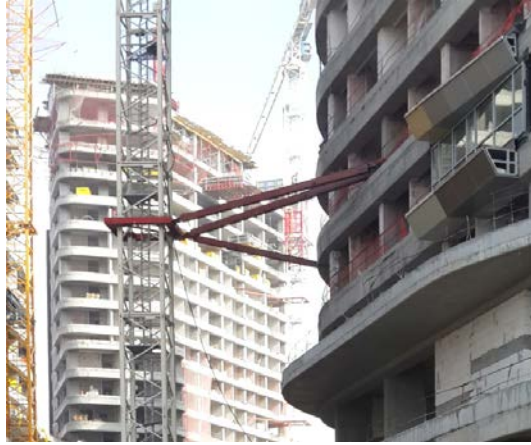
Şekil 39. Örnek bina bağlantı noktası
