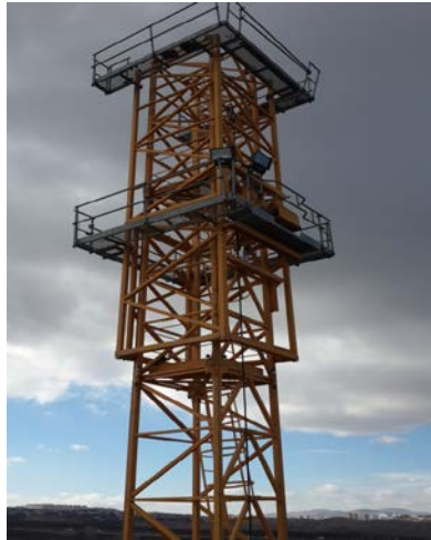
Şekil 77. Kule vinç teleskop aparatı ve gövdenin kalan kısmı
