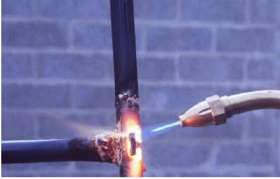
Şekil 4.4 İnşaat – Sessiz pürmüz kullanılması
