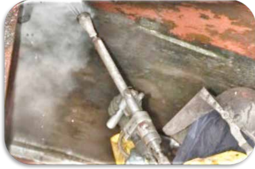
Şekil 3.17. Kapalı Alanda Su Püskürtme ile Temizleme
