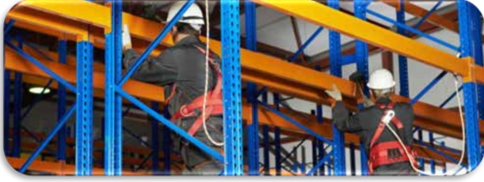
Şekil 3.18. Gerekli Önlemlerin Alındığı Raf Montajı
