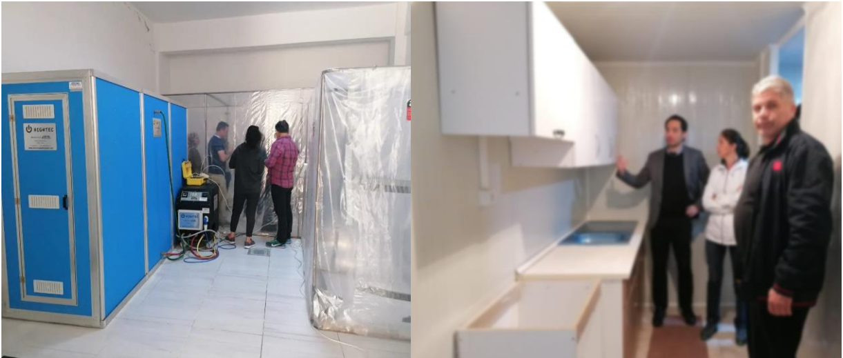
Fotoğraf 1.4 Asbest Sökümü Uygulama Merkezi
