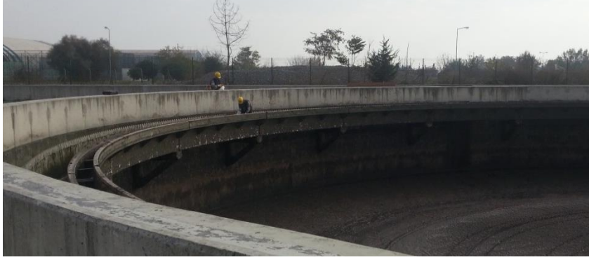
Resim 4. 6. Son çökeltme havuzu savaklarının temizlenmesi
