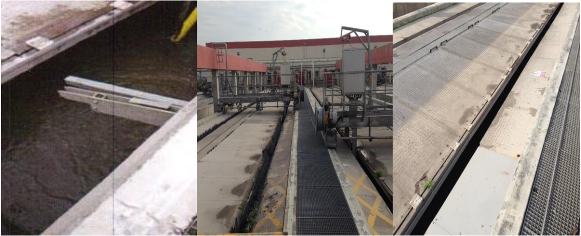
Resim 4. 5. Kum ve yağ tutucu havuzlarda düşmeye neden olabilecek tehlikeler
