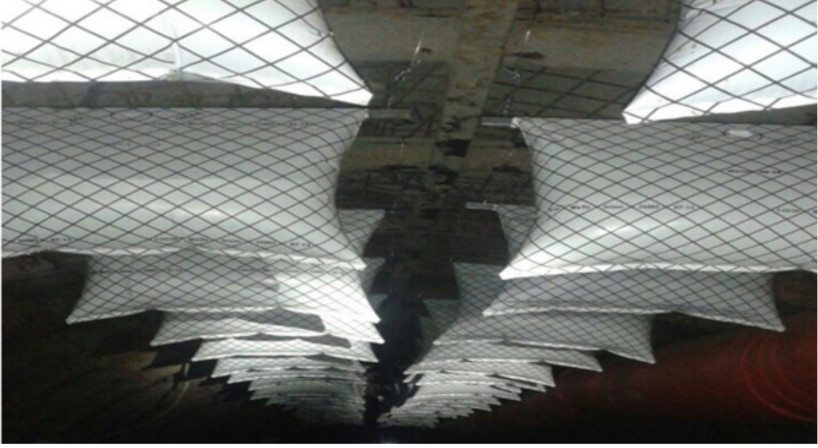
Fotoğraf 1: Kömür madeninde su barajı
