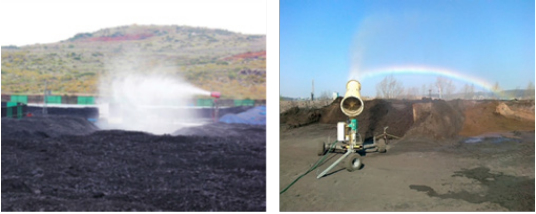
Fotoğraf 25: Kömür stoğunda toz bastırma sistemi
