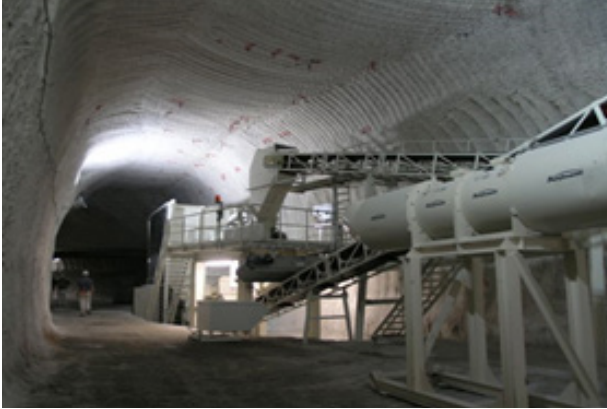
Fotoğraf 9: Tuz madeni konveyör tozsuzlaştırma
