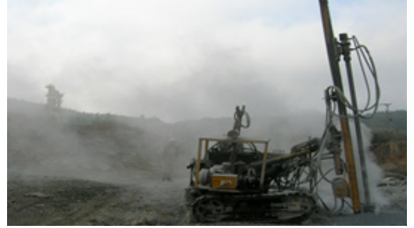
Fotoğraf 17: Delik delme işleminde toz oluşumu
