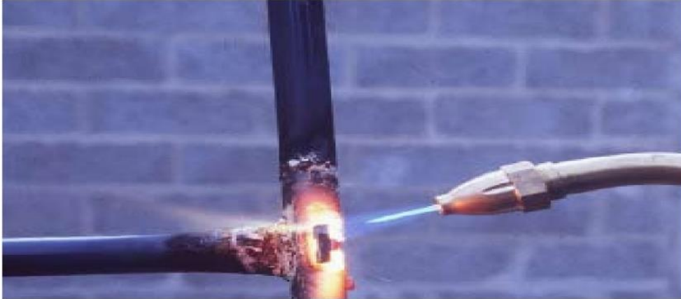
Şekil 2.8 İnşaat – Sessiz pürmüz kullanılması
