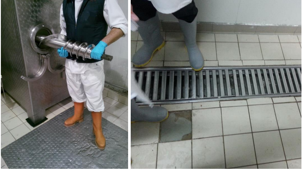
Resim 2.12. Uygun olmayan zeminler
