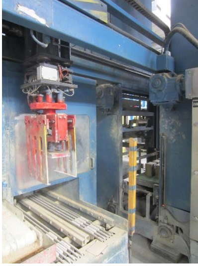
Şekil 70. Lazer perde uygulaması
