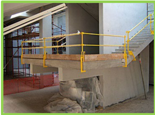
Şekil 5.11. Kat merdivenlerinde düşmeye karşı koruma [37]
