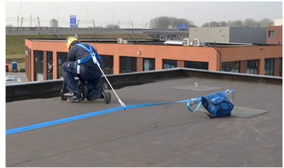
Şekil 3.7. Hareketi kısıtlayıcı sistem [13]
