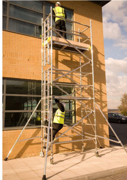
Şekil 4.9. Erişim kulesi ile çalışma [30]
