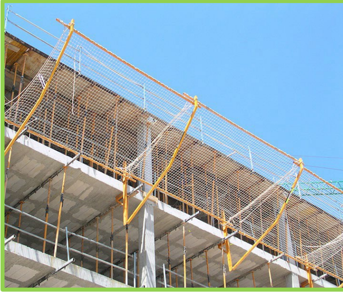
Şekil 5.10. Güvenlik ağı ile düşmeye karşı koruma [36]
