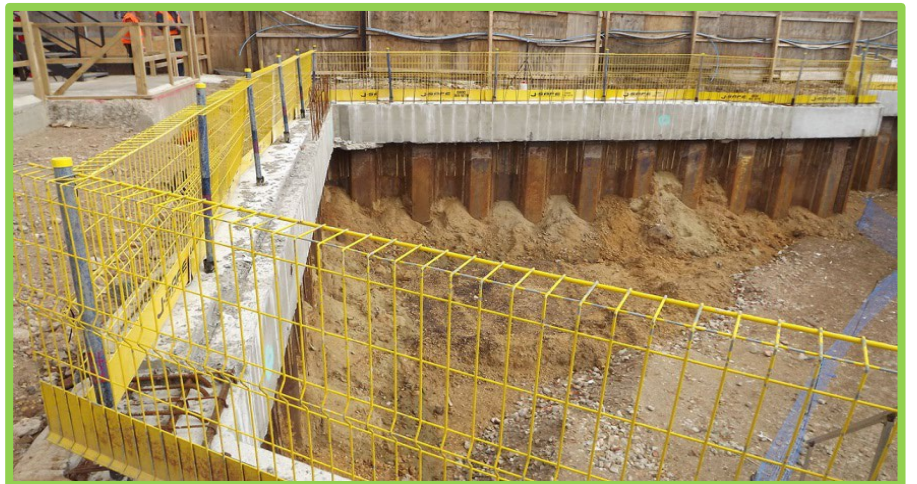
Şekil 5.6. Kazı kenarında düşmeye karşı koruma [33]
