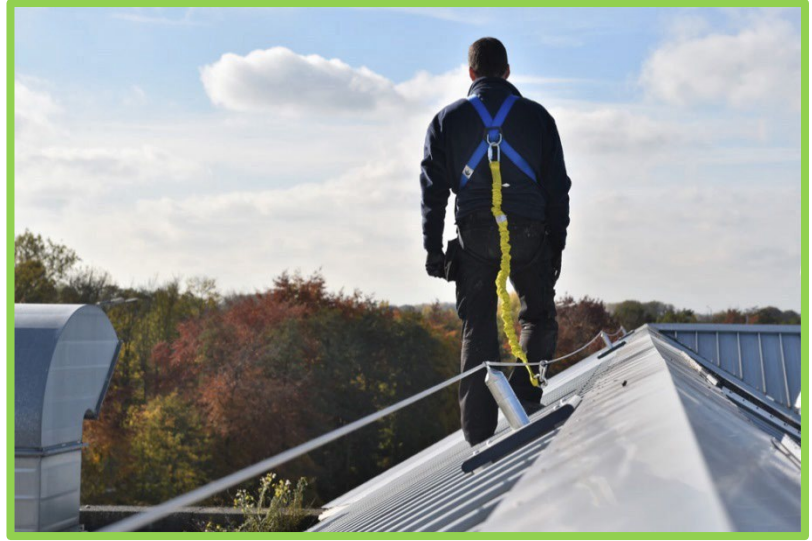
Şekil 5.8. Yaşam hattı ile düşmeye karşı koruma [35]
