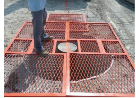
Şekil 3.6. Kapak sistemi [12]
