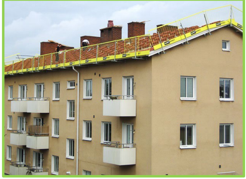
Şekil 5.7. Çatı çalışmasında düşmeye karşı koruma [34]
