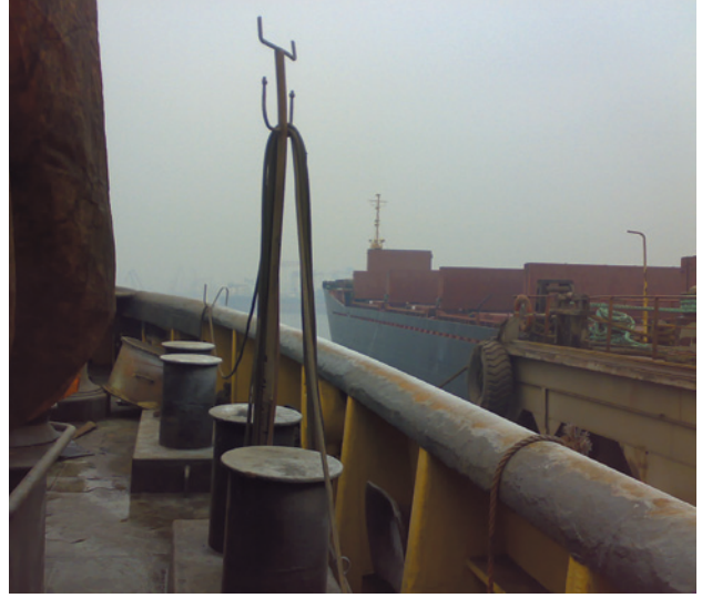
Tamir gören gemi içinde askılarla iletilmiş seyyar kablolar
