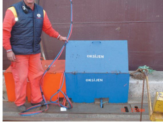
Uygun Olmayan ve Olan LPG, Oksijen Dağıtım Noktaları
