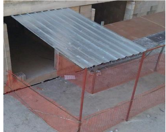
Şekil 3-13. Kat Platform Kenarlarından Malzeme Düşme Riski – İnşaat Girişine Koruma Çatısı
