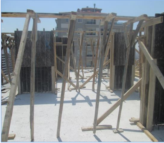
Şekil 3-7. Kalıp Altı Desteklerde Göçme/Devrilme Riski – Kalıp Altı Teleskopik Dikmeler
