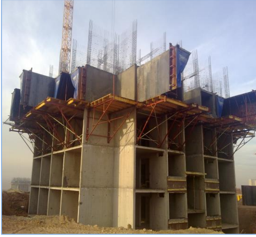
Şekil 3-6. Tünel Kalıplarda Düşme Riski – Tünel Kalıp Kenarlarında Korkuluk Sistemi
