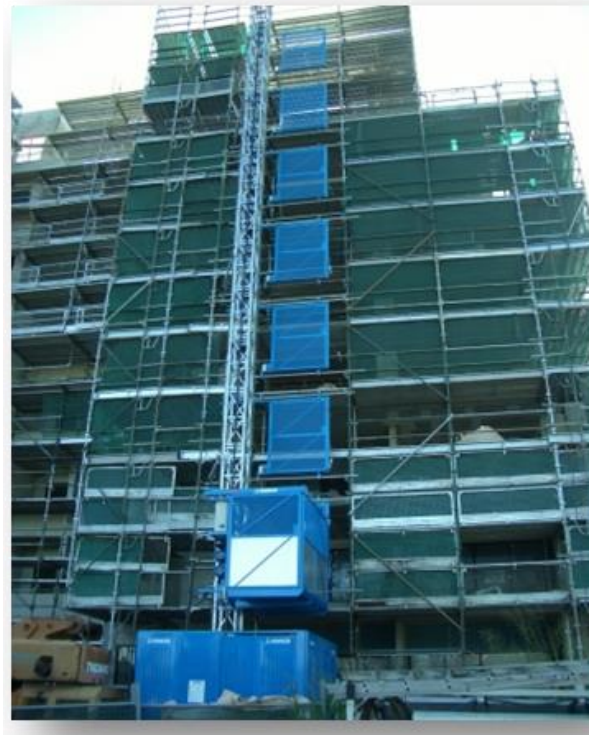
Şekil 3-15. İnşaat Asansörü ile Çıkılan Katlarda Düşme Riski - Katlarda Emniyet Kapıları
