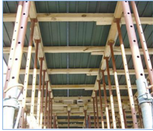
Şekil 3-7. Kalıp Altı Desteklerde Göçme/Devrilme Riski – Kalıp Altı Teleskopik Dikmeler
