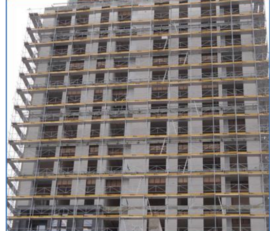
Şekil 3-10. Dış Cephe İş İskelesinde Düşme Riski – Uygun Cephe İskelesi
