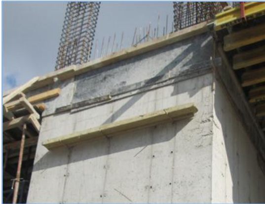
Şekil 3-9. Perde Duvar Kalıp Çalışmalarında Düşme Riski – Korkuluklu-Platformlu Perde Duvar Kalıbı
