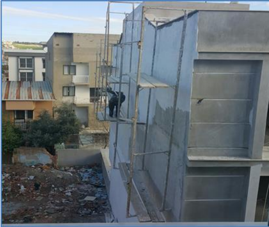
Şekil 3-10. Dış Cephe İş İskelesinde Düşme Riski – Uygun Cephe İskelesi
