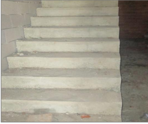
Şekil 3-7. Merdiven Kenarlarında Düşme Riski – Merdiven Boşluğu Kenarında Korkuluk Sistemi
