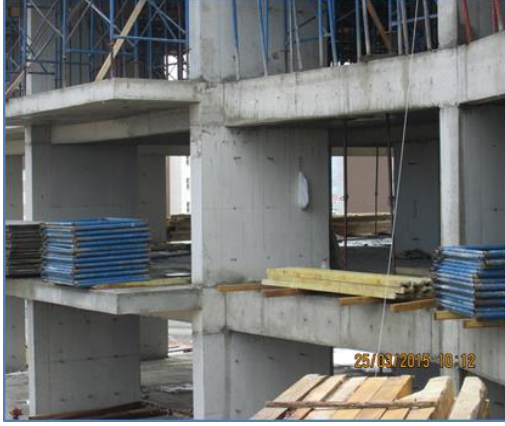
Şekil 3-12. Yük Alma Platformundan Düşme Riski – Düşme Riski Barındırmayan Yük Alma Platformu
