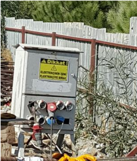
Şekil 3-16. Koruma Altına Alınmamış Elektrik Panoları – Uygun Elektrik Panosu
