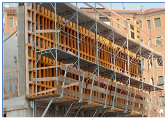
Şekil 3-9. Perde Duvar Kalıp Çalışmalarında Düşme Riski – Korkuluklu-Platformlu Perde Duvar Kalıbı
