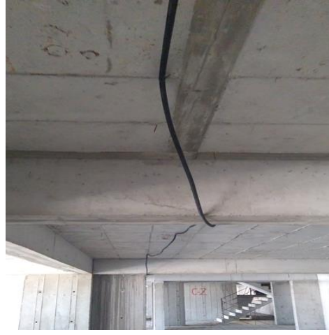
Şekil 3-17. Ezilme Riskine Maruz Kalmış Seyyar Elektrik Kabloları – Askıda Taşınan Kablolar
