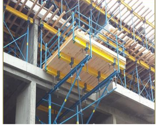
Şekil 3-12. Yük Alma Platformundan Düşme Riski – Düşme Riski Barındırmayan Yük Alma Platformu
