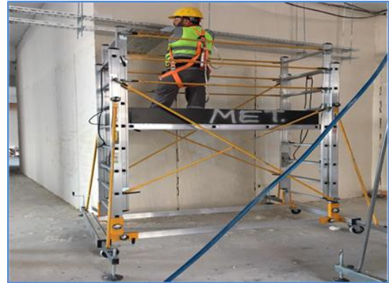
Şekil 3-8. Seyyar İskelelerde Yapılan Çalışmalarda Düşme Riski – Uygun Seyyar İş İskelesi
