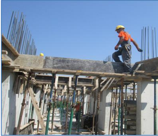
Şekil 3-8. Kalıp Çalışmalarında Düşme Riski ve Bu Aykırılığa İlişkin Alınabilecek Önlem
