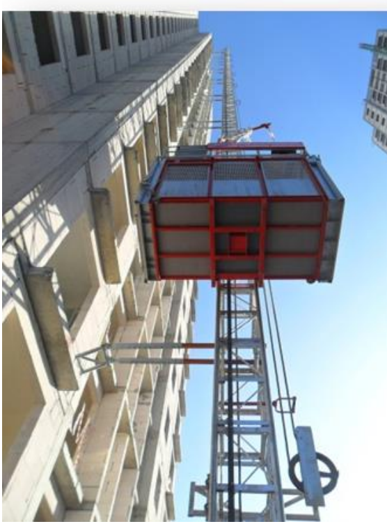
Şekil 3-15. İnşaat Asansörü ile Çıkılan Katlarda Düşme Riski - Katlarda Emniyet Kapıları
