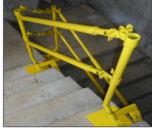
Şekil 3-7. Merdiven Kenarlarında Düşme Riski – Merdiven Boşluğu Kenarında Korkuluk Sistemi
