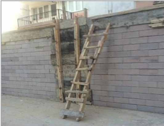
Şekil 3-11. Uygun Olmayan Seyyar Merdiven - Standartlara Uygun Seyyar Merdiven
