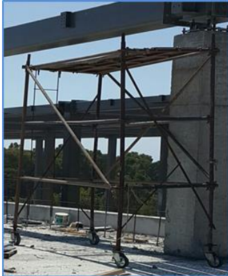
Şekil 3-8. Seyyar İskelelerde Yapılan Çalışmalarda Düşme Riski – Uygun Seyyar İş İskelesi
