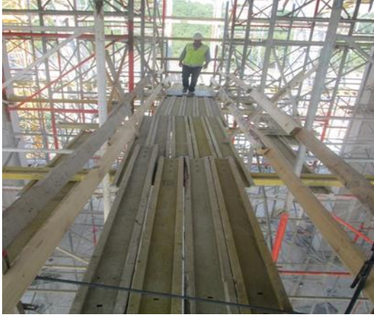
Şekil 3-9. Kule Tipi Kalıp Altı İskelelerde Düşme Riski – Erişim Sistemi Olan Kule Tipi Kalıp Altı İskele Sistemi
