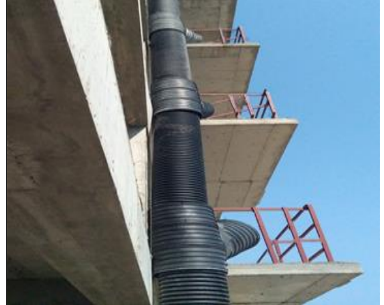
Şekil 3-14. İşyeri Düzeni ve Temizliğine İlişkin Mevzuata Aykırılık- Atık Moloz Kaydırma/Atma Bacası
