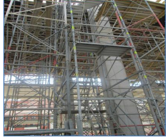
Şekil 3-9. Kule Tipi Kalıp Altı İskelelerde Düşme Riski – Erişim Sistemi Olan Kule Tipi Kalıp Altı İskele Sistemi
