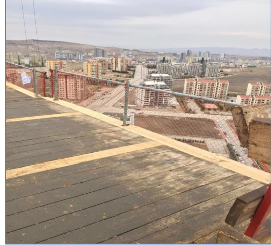
Şekil 3-6. Tünel Kalıplarda Düşme Riski – Tünel Kalıp Kenarlarında Korkuluk Sistemi
