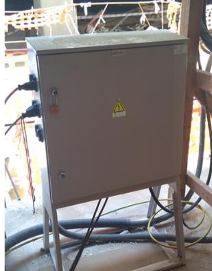
Şekil 3-16. Koruma Altına Alınmamış Elektrik Panoları – Uygun Elektrik Panosu
