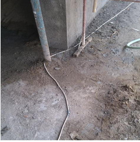
Şekil 3-17. Ezilme Riskine Maruz Kalmış Seyyar Elektrik Kabloları – Askıda Taşınan Kablolar
