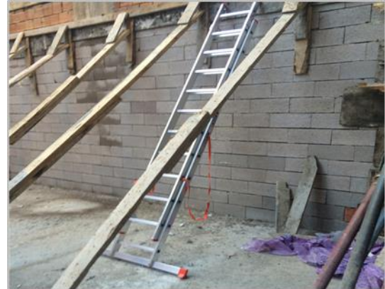
Şekil 3-11. Uygun Olmayan Seyyar Merdiven - Standartlara Uygun Seyyar Merdiven
