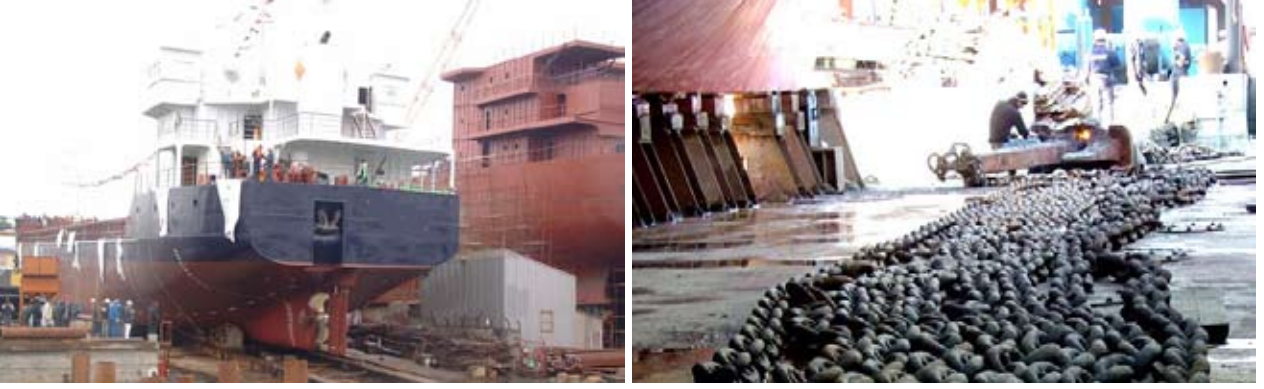
Tersanelerde yapılan çeşitli işlerden görüntüler
