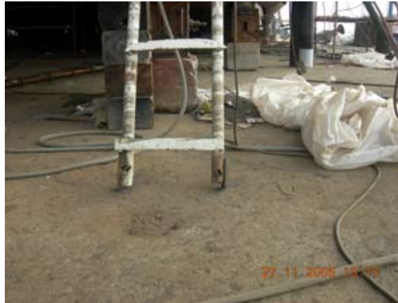
Uygun olmayan seyyar merdiven
