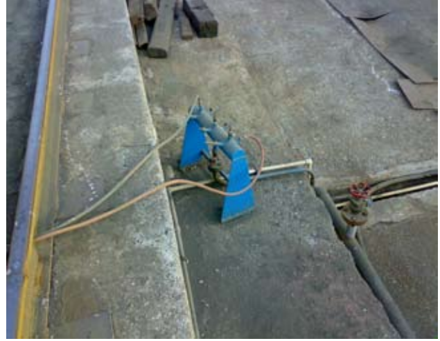
Uygun olan ve olmayan LPG ve oksijen dağıtım noktaları
