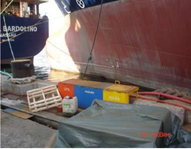
Uygun olan ve olmayan LPG ve oksijen dağıtım noktaları
