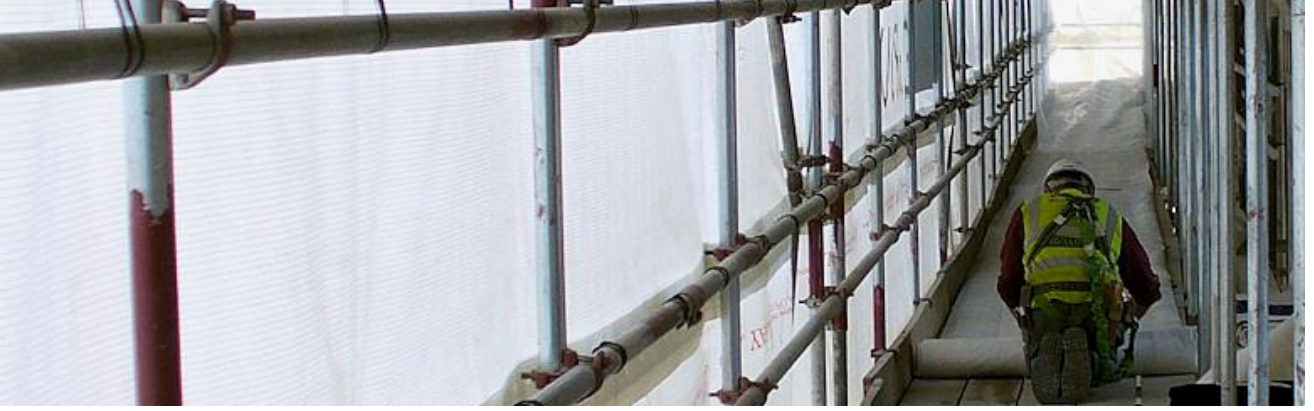
Şekil 40: İskeleye kaplama yapılması
