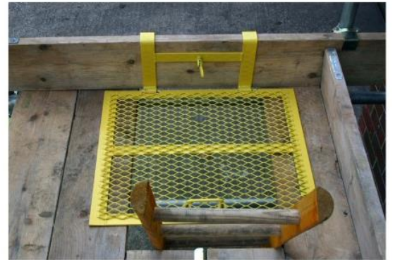
Şekil 23: Merdiven ulaşım açıklığı
