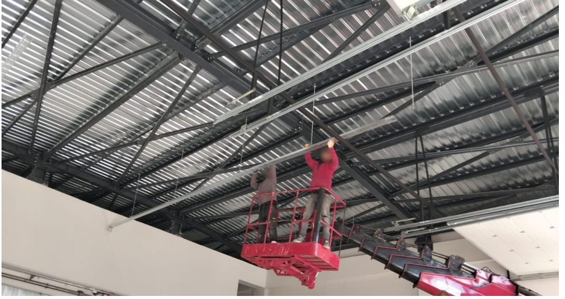
Resim 3.3. YSİP ile gerekleřtirilen ve ezilme-sıkıřma ihtimali olan uygunsuz bir alıřma
