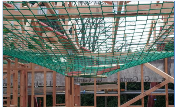
Şekil 26: Ağ üzerine düşen cisimler
