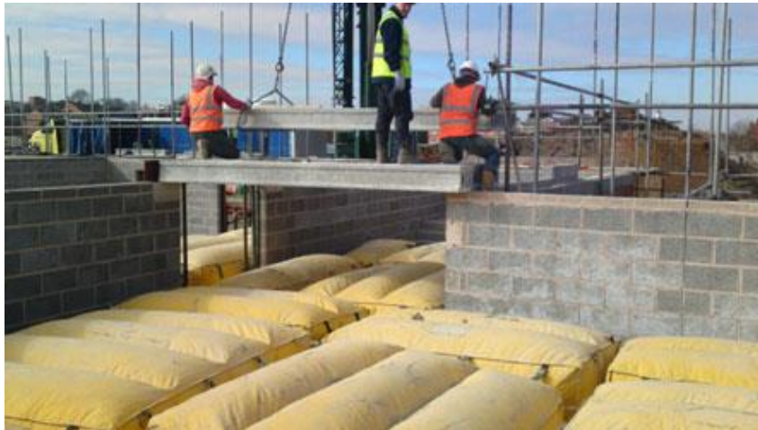
Şekil 2: Düşmeye karşı hava yastıklarının kullanımı
