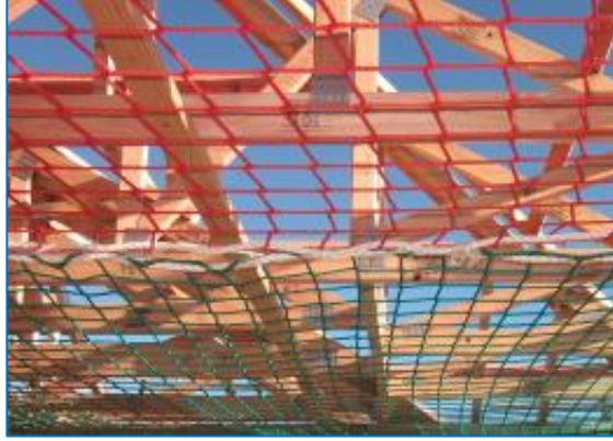
Şekil 21: Ağların birleştirme ipi ile bir araya getirilmesi
