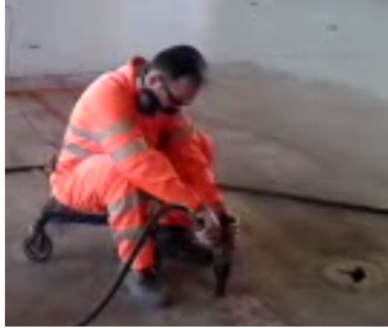
Şekil 2.10. Raspa İşlemi Esnasında Tekerlekli Destek Ekipmanı Kullanımı
