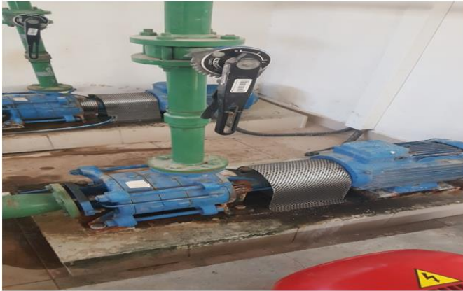
Şekil 3.8 - Ekipmanların Hareketli Parçalarıyla Temas Riskinin Önlenmesi
