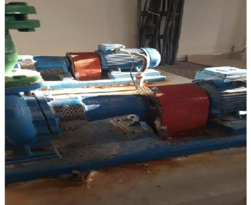
Şekil 3.8 - Ekipmanların Hareketli Parçalarıyla Temas Riskinin Önlenmesi
