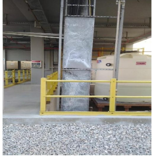
Şekil 3.4 - Açıktaki Kablo Tavalarının Düzenlenmesi
