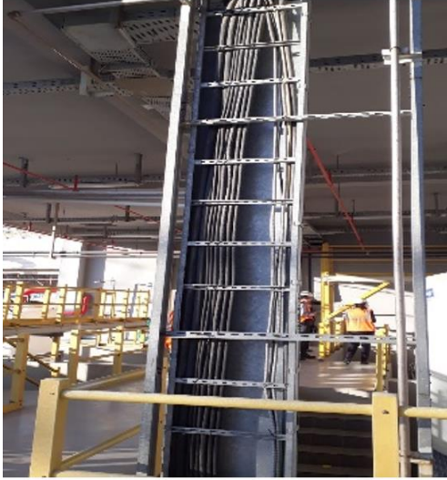
Şekil 3.4 - Açıktaki Kablo Tavalarının Düzenlenmesi
