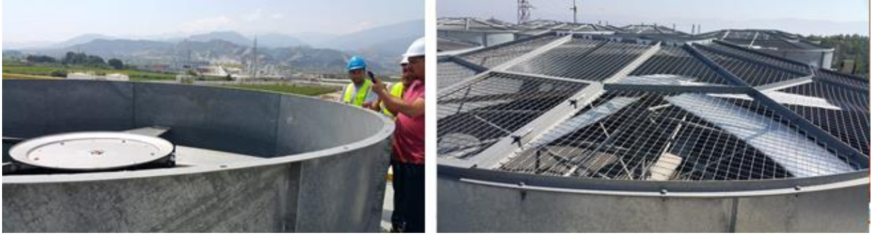
Şekil 3.9 - Kondens Fanlarının Üst Kısımının Temas Riskine Karşı Kapatılması
