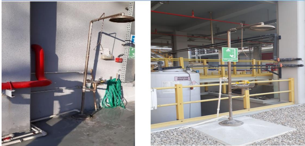
Şekil 3.1 - Göz Duşu Tesis Edilmesi
