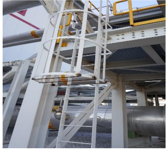
Şekil 3.3 - Kullanılmayan Tehlikeli Bölgeye Erişimin Engellenmesi
