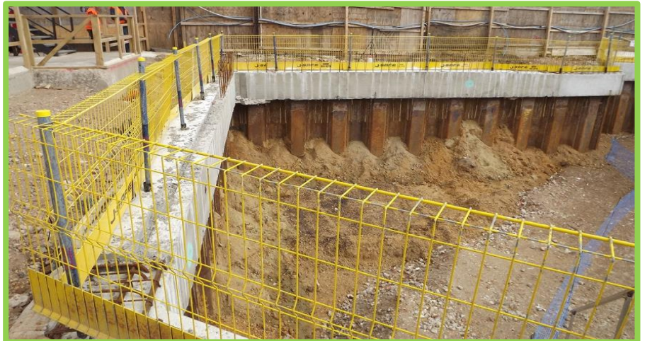
Şekil 5.6. Kazı kenarında düşmeye karşı koruma [33]
