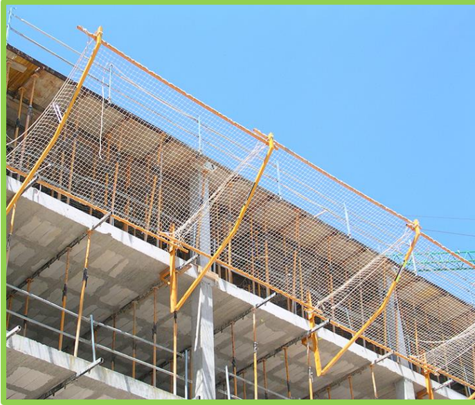
Şekil 5.10. Güvenlik ağı ile düşmeye karşı koruma [36]
