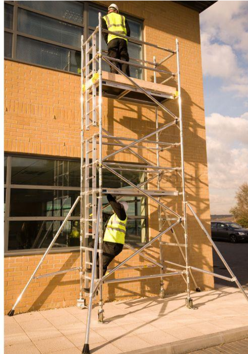
Şekil 4.9. Erişim kulesi ile çalışma [30]
