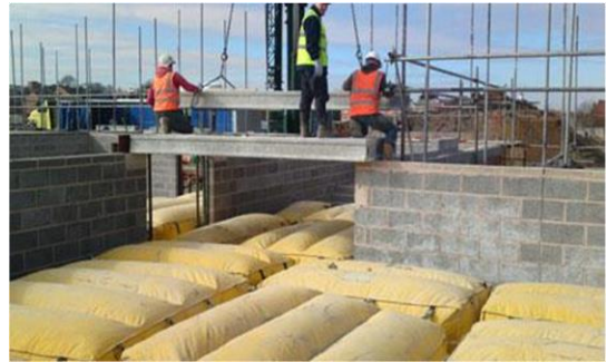
řekil 3.14. Hava yastıęı sisteminin bir inřaatta kullanımı [19]
